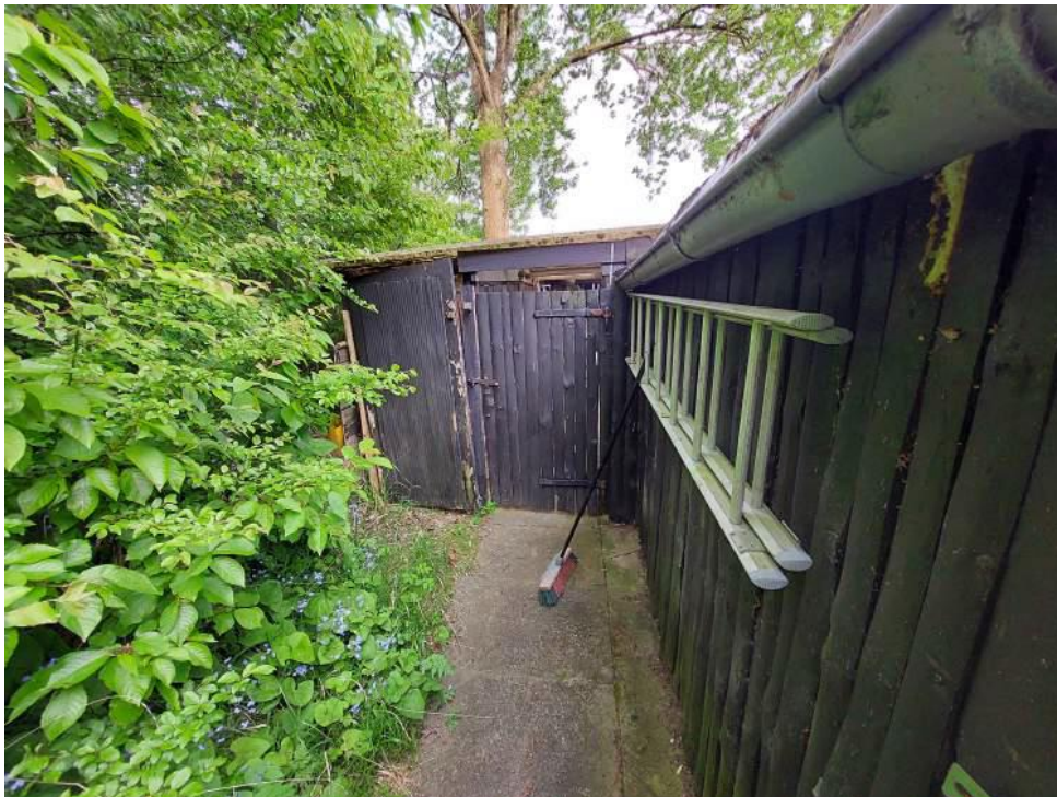
Facade mod vest og bagsiden af overdækningen.
