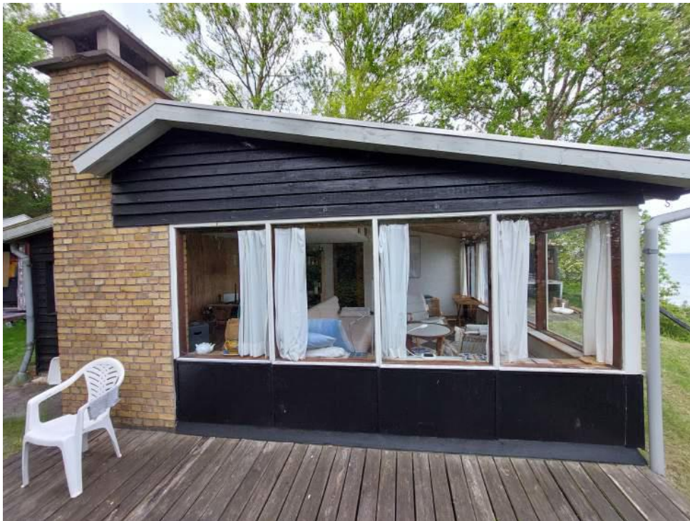
Facaden mod syd og foranliggende terrasse
