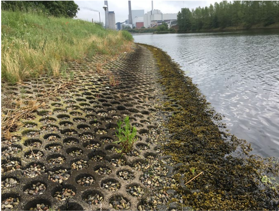
Figur 1 Hulfliser udlagt som sikring mod erosion af brinkerne på Odense Kanal
