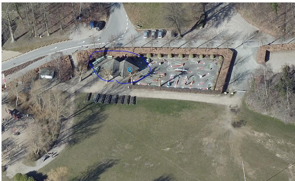
Skråfoto fra 2017 viser den nu nedbrændte bygning (markeret med blå).
