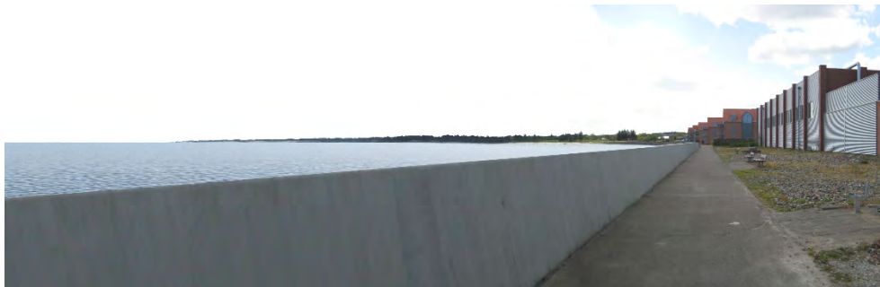
Eksisterende forhold, set mod syd langs promenaden – sommer. Denne visualisering bygger på et panoramabillede og skal derfor ses tæt på, i en afstand på kun 5 cm (i A3 18 cm)
