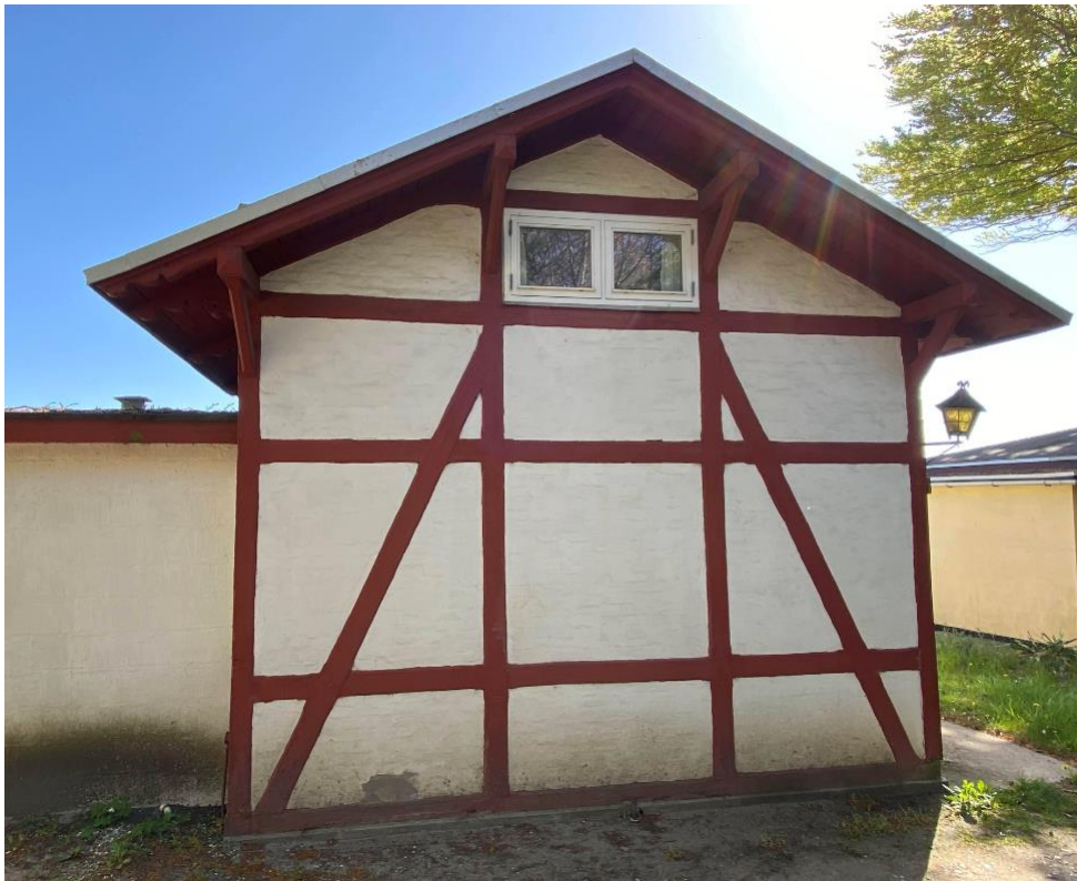
Eksisterende facade mod land
