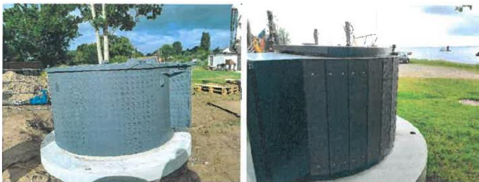
Fig. 5. viser eksempler på, hvordan den synlige del af anlægget ved Ejby Havnevej (toppen) kan komme til at se ud. Indsat fra ansøgning
