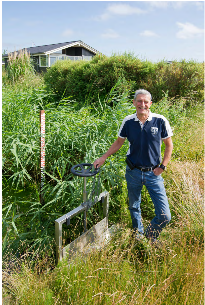
Peter Svane-Knudsen ved åen i As Vig. Der blev sat en højvandsklap i åen for at forhindre tilbageløb og dermed sikre, at der ikke kommer vand ind bag diget fx i tilfælde af stormflod eller ekstremt højvande.
