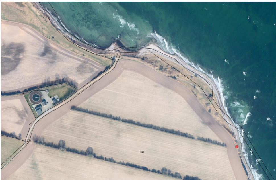
Luftfoto viser renseanlægget mod vest og omtrentlig placering af eksisterende udløbsbygværk ved den røde prik.
