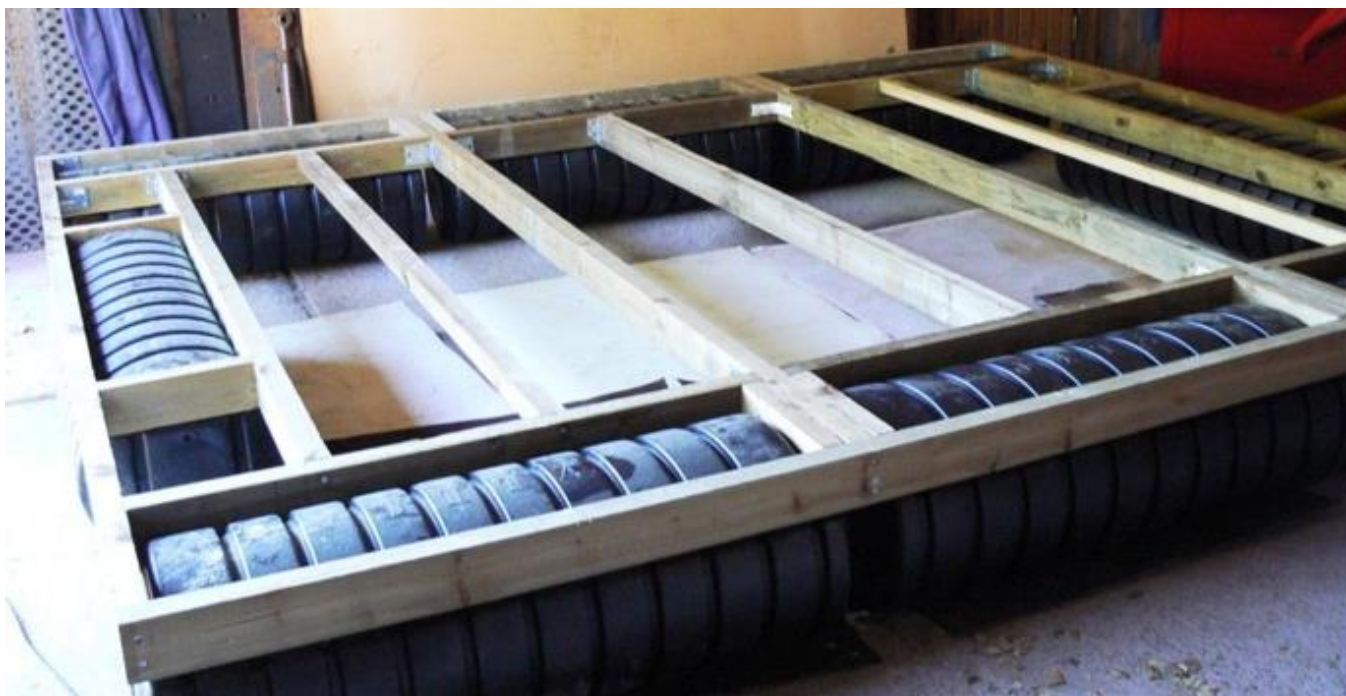
Grundkonstruktionen på flydeplatformen.
