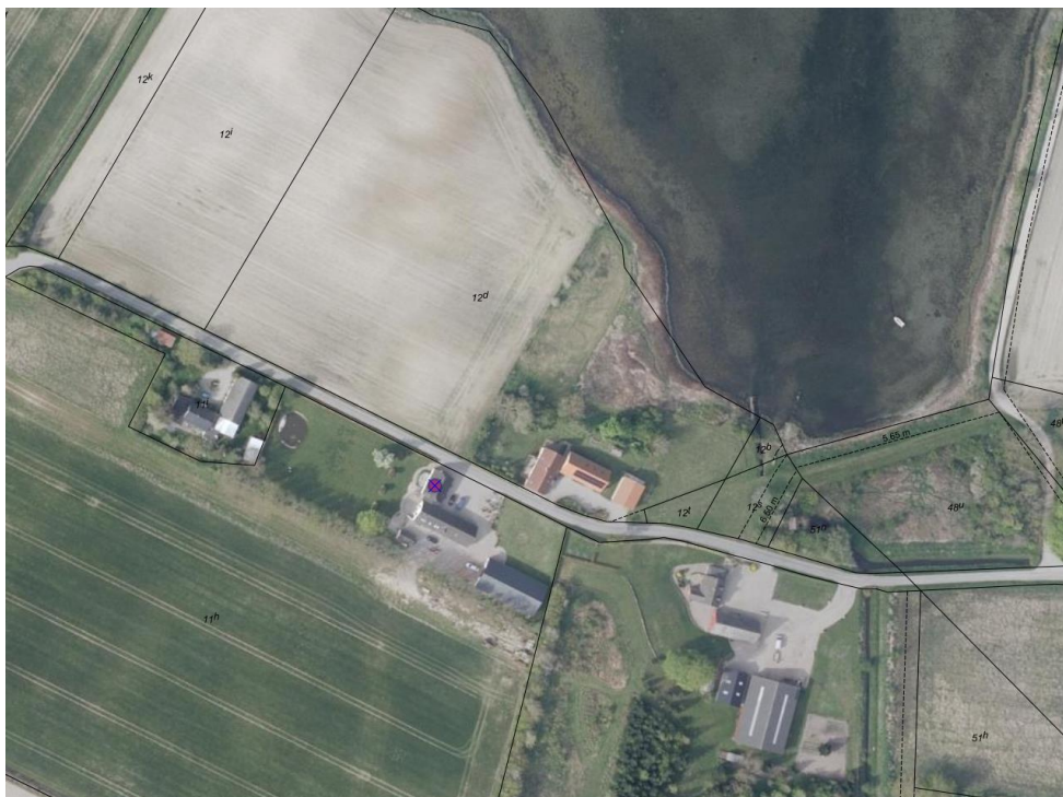
Luftfoto af området. Stuehuset er markeret med rød prik. Ejendommens øvrige bygninger ligger umiddelbart syd herfor. Sorte streger er matrikelskel.
