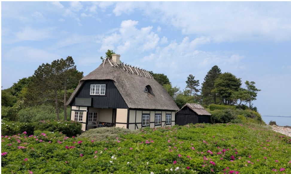
Foto af bygningerne set fra syd. Udhus i baggrunden.
