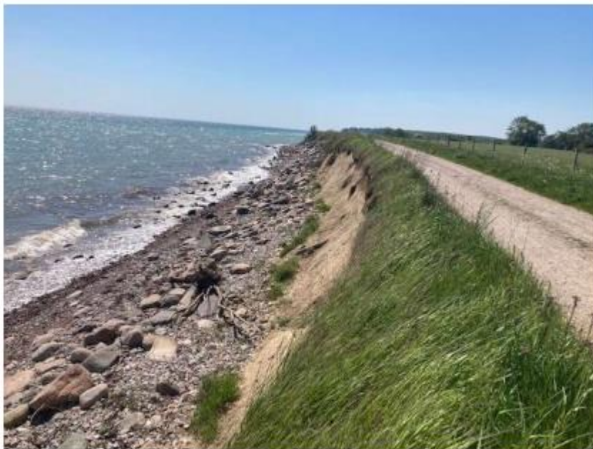
Foto af klint og vejstrækning fra position B mod syd.
