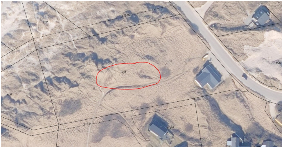
Luftfoto af ejendommen. Omtrentlig placering af sivedræn er markeret med rød.
