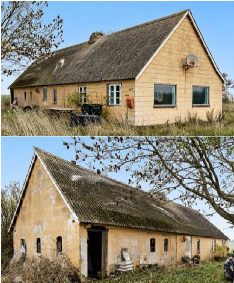
Figur 2: Billeder af det eksisterende hus. Øverst ses nordvendt gavl, nederst ses sydvendt gavl.
