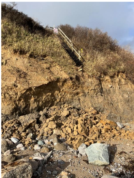
Figur 5 - Den eksisterende ståltrappe d. 15-11-2023
