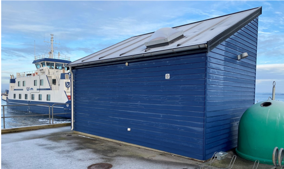
Fig. 4. Eksisterende servicebygning på Venø Færgeleje
