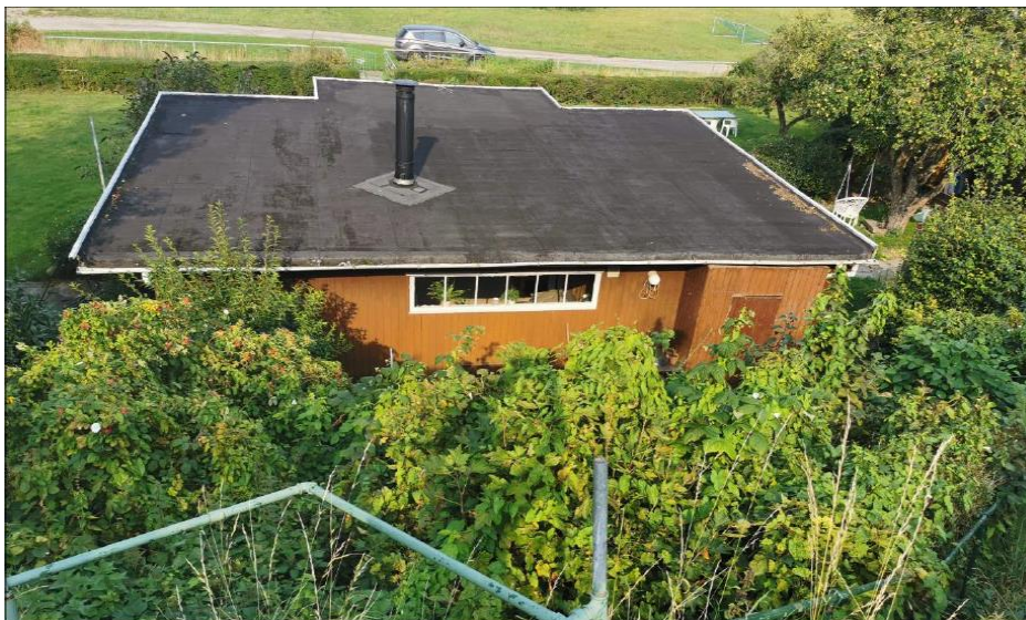
Skråning mod syd set fra top af skråning.
