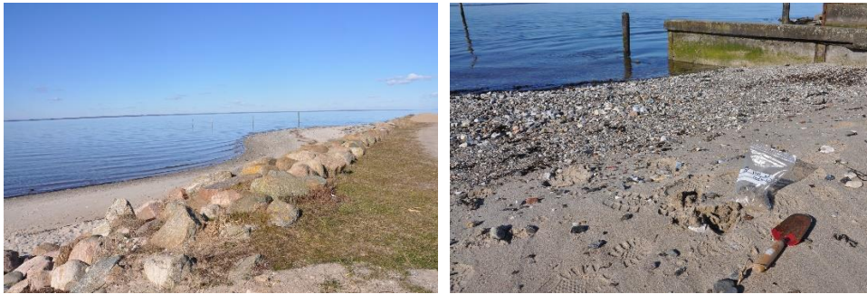
Figur 5: Skråningsbeskyttelse vest for indsejlingen (til venstre) med finkornede aflejringer (til højre).
