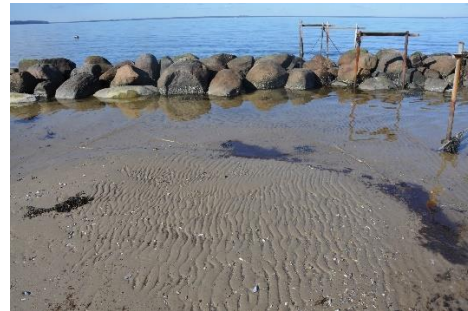
Figur 8: Bølgebryder med aflejring af sand i tomboloformation (til venstre) og mere finkornet materiale (til højre).
