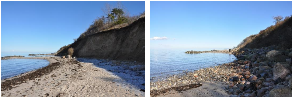
Figur 11: Aktive kystklinter ved bølgebryderne, delvist med skråningsbeskyttelse.
