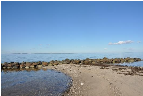
Figur 8: Bølgebryder med aflejring af sand i tomboloformation (til venstre) og mere finkornet materiale (til højre).
