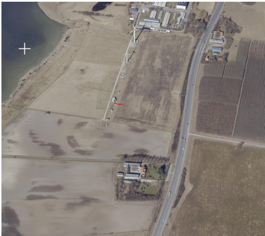
Bygning 322 ligger ved rød markering
