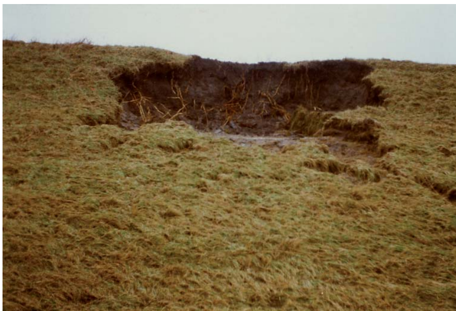
Figur 6 Tværprofil af digeskår fra station 3,1 Rejsby dige efter stormfloden 3 januar 1976, ref. /13/.
