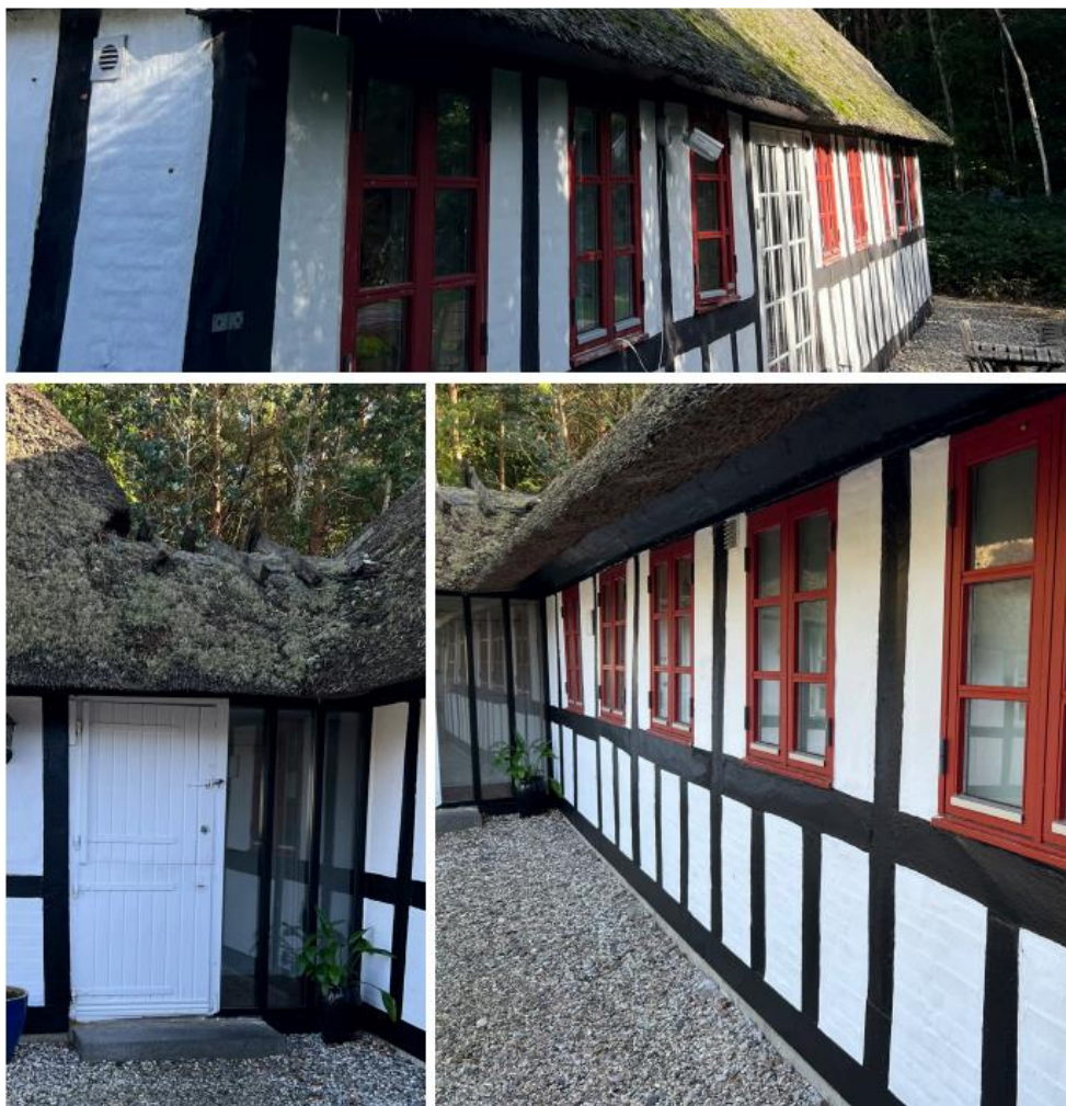
Fig. 4. Tilsendt af ansøger. På figuren ses et billede af de eksisterende forhold på bygning 1.
