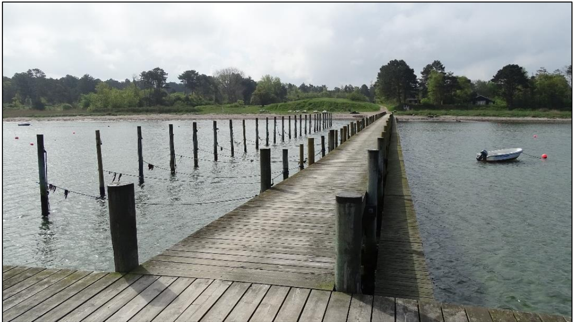
Figur 5: Billedet viser bade- og bådebroen fra brohovedet mod land. Øst for broen (til venstre i foto) ses fortøjningspælene (i alt 48 stk.) som udgør 23 pæle-fortøjningspladser. Vest for broen ses en båd fortøjet til én af de 77 svajepladser, som består af en galvaniseret P-ring (se foto nedenunder) med ankerkæde og bøjle.
