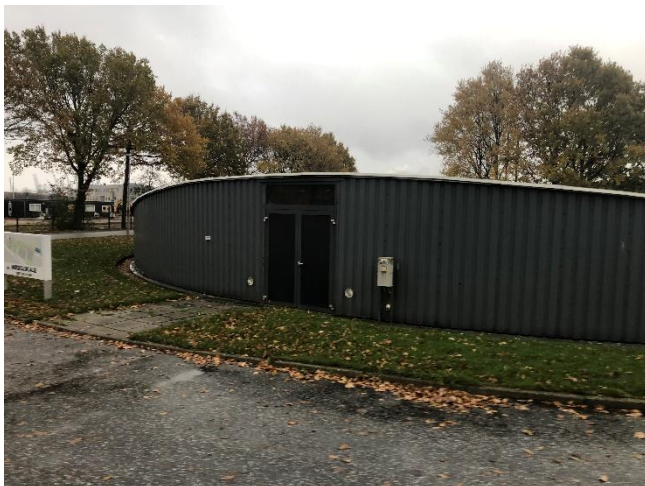
Bygning 16 – Udlignings- og primærtanke (2 stk.)
