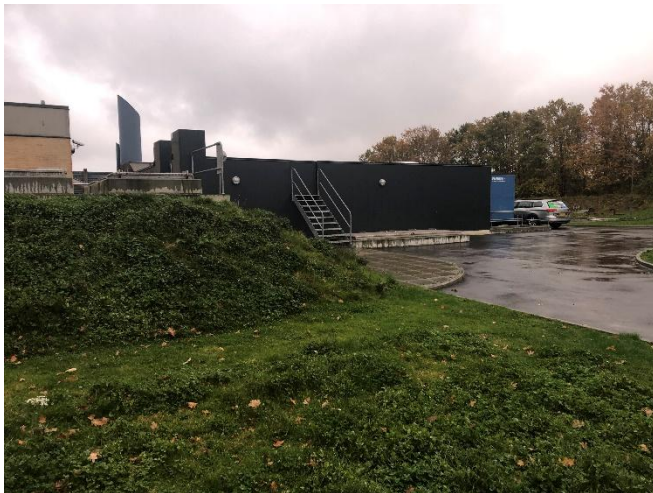
Bygning 20 – Pumpestation - NEDRIVES IKKE
