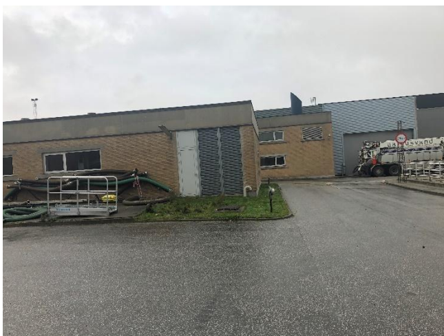
Bygning 12 – Slamafvandingsbygning - udløbs-pumpestation
