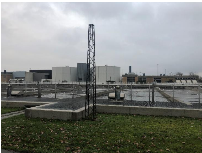
Bygning 7 – Rådnnetanke i baggrunden. Foranliggende efterklaringstanke (bygning nr. 9). Gasmotorbygning (nr. 6) til højre for rådnnetanke.
