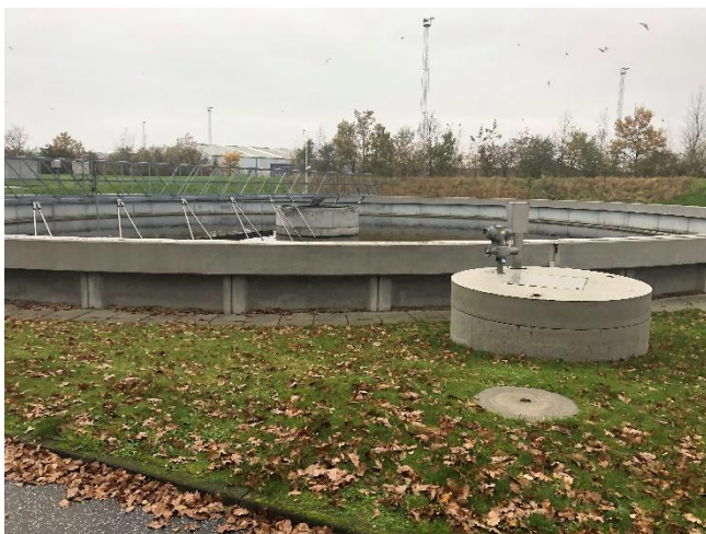
Bygning 2 – 2 stk. efterklaringstanke
