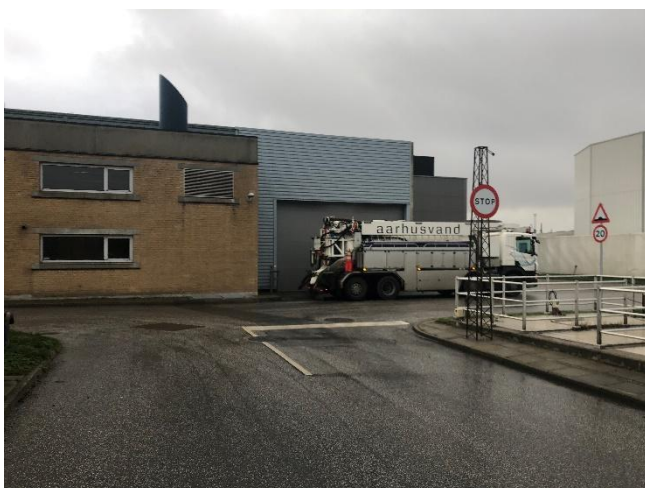
Bygning 11 – Slambehandlingsbygning og P-genvindingsanlæg (til højre)
