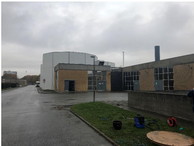
Bygning 6 – Gasmotorbygning, med bagvedliggende rådnnetanke (bygning nr. 7)
