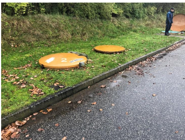
Bygning 10 – Kemikalietanke (2 stk. Tunøtanke) 30 m 3
