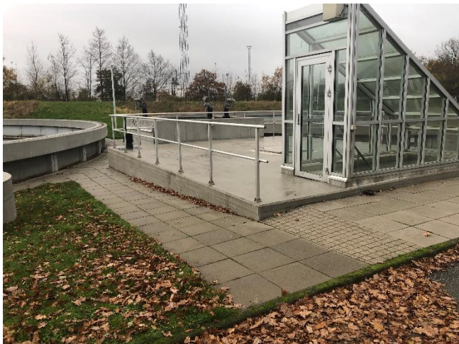
Bygning 3 – Kombibygværk - Flydeslamsbrønd
