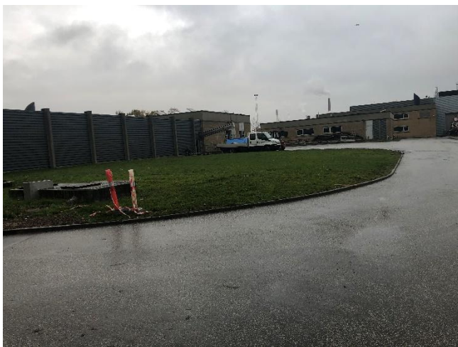
Bygning 13 – Sand og fedtfang
