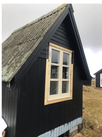
Nyt vindue, der er af træ og malet med farven Lys Hamp. Jeg er ikke færdig med inddækninger.
