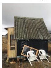
Facade set fra øst mod vest, foto fra 13-03-2025.
