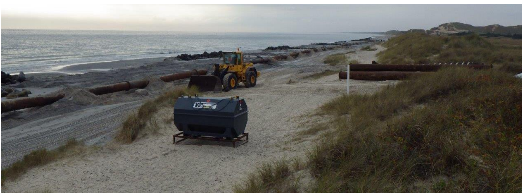
Figur 3-11. Indpumpning med bundliggende rørledning med maskiner til håndtering af rør.
