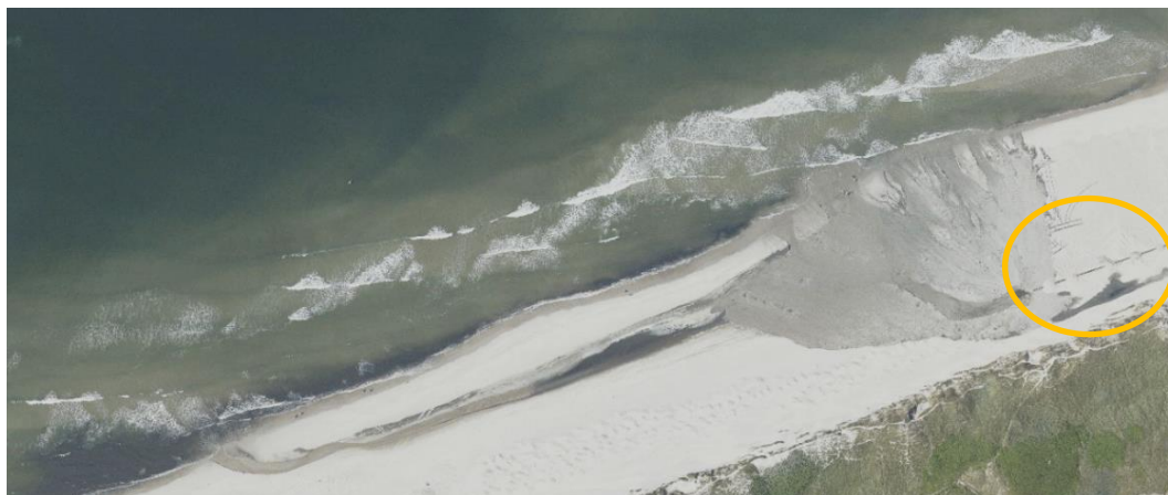
Figur 7-29. Sandfodring med rørledning ved Årgab omkring Søndergade 92 . Rørledningen er markeret med orange cirkel.
