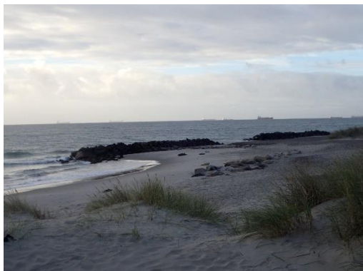
Hård kystbeskyttelse i form af t-høfde.
