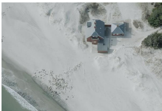
Figur 17-13. Bygningerne på Gl. Fyrvej 12 har bevaringsværdi 2.
