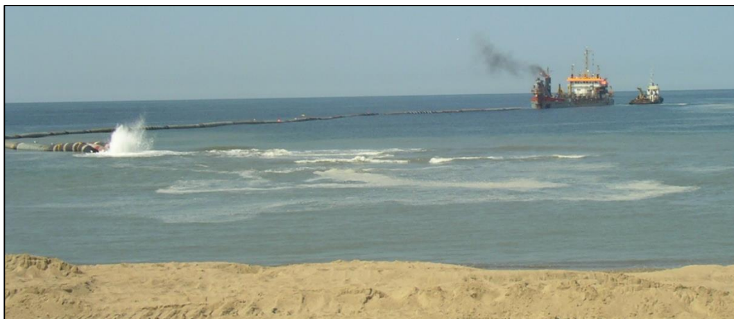
Figur 3-12. Kystnær fodring ved indpumpning med flyderørledning.
