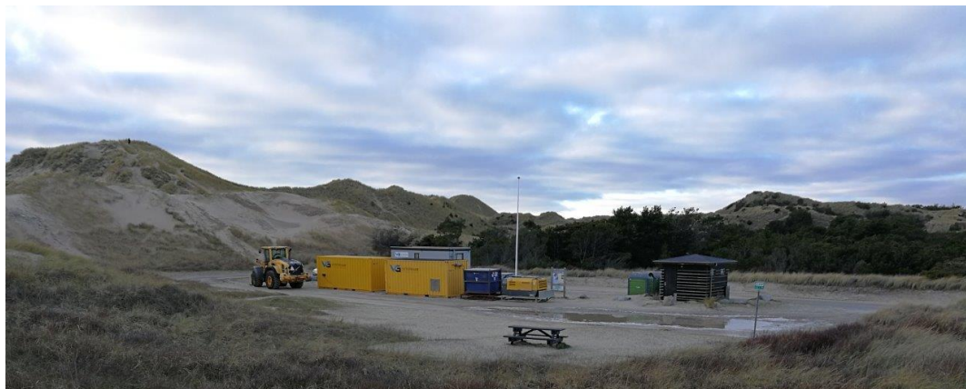
Figur 3-19. Foto fra arbejdsplads ved Damstederne.
