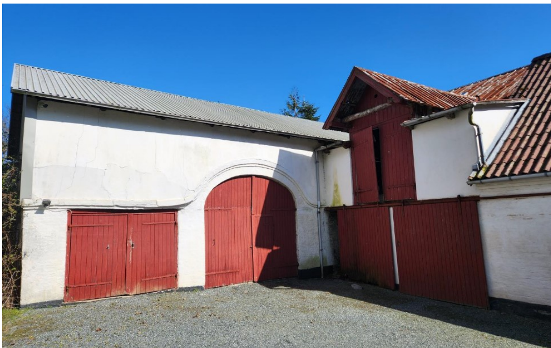
Eksisterende facade mod vest set fra gårdspladsen
