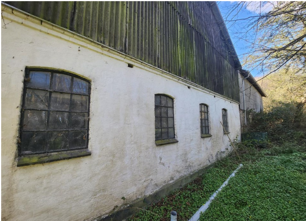
Eksisterende facade mod øst. Sydlig del.
