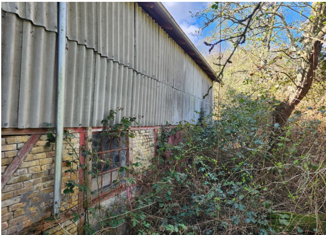
Eksisterende facade mod øst. Nordlig del.
