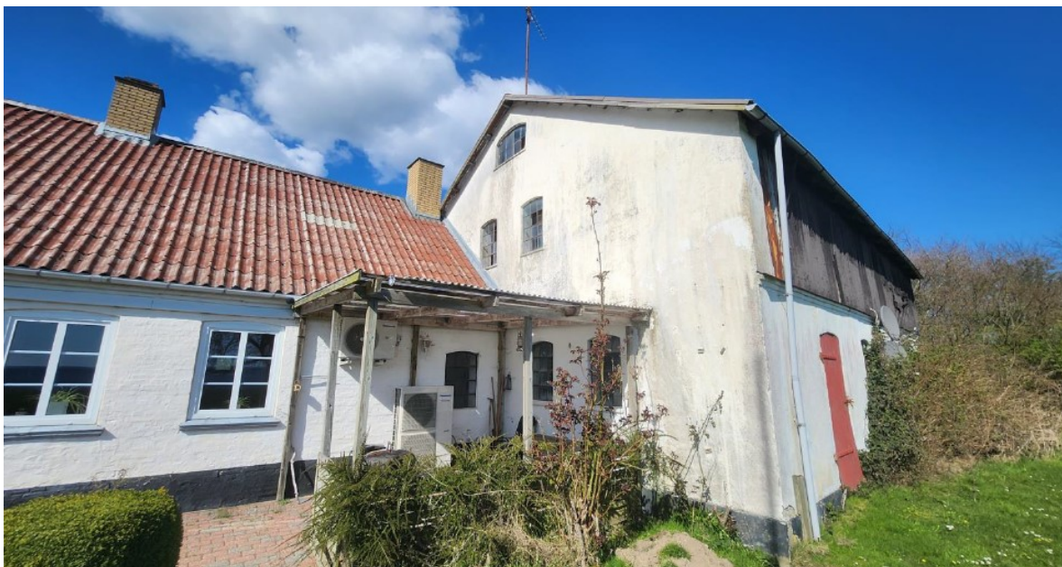
Eksisterende facade mod vest set fra sydvest
