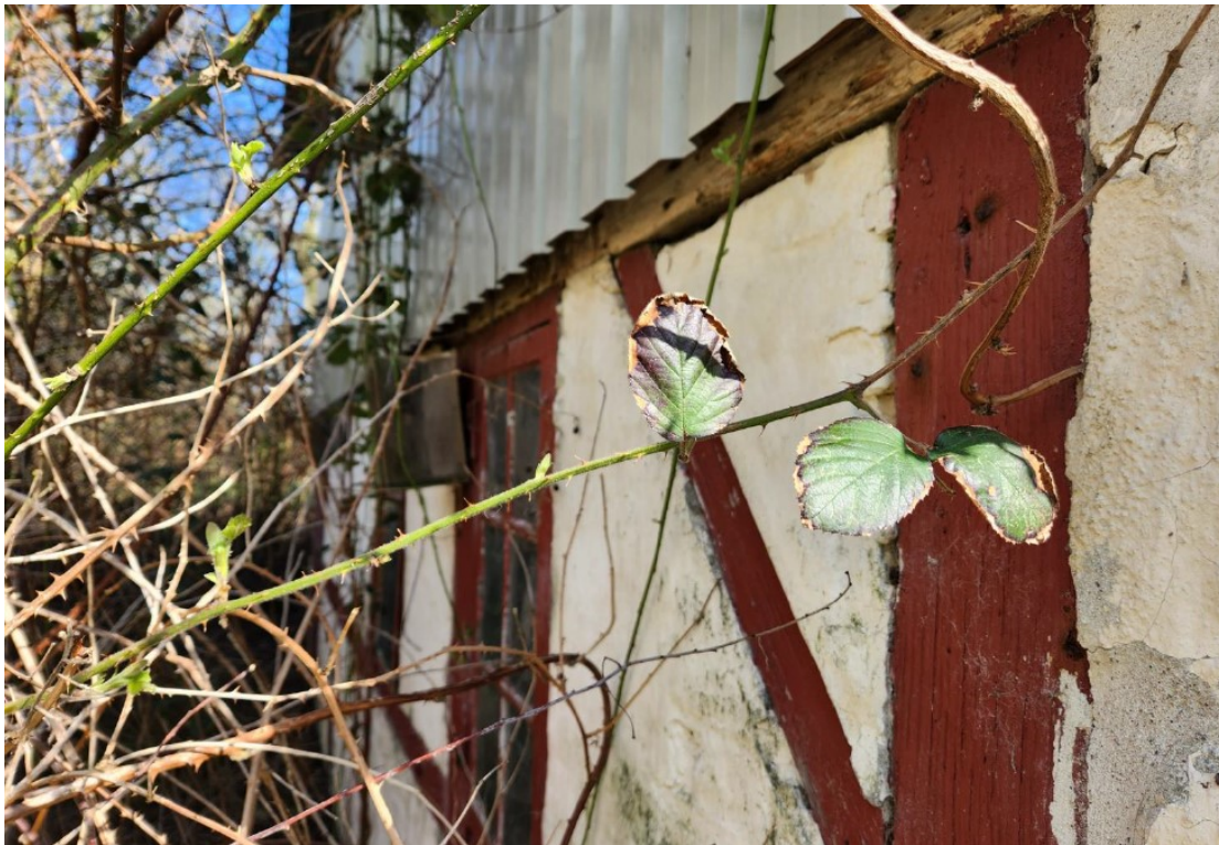
Eksisterende facade mod nord.
