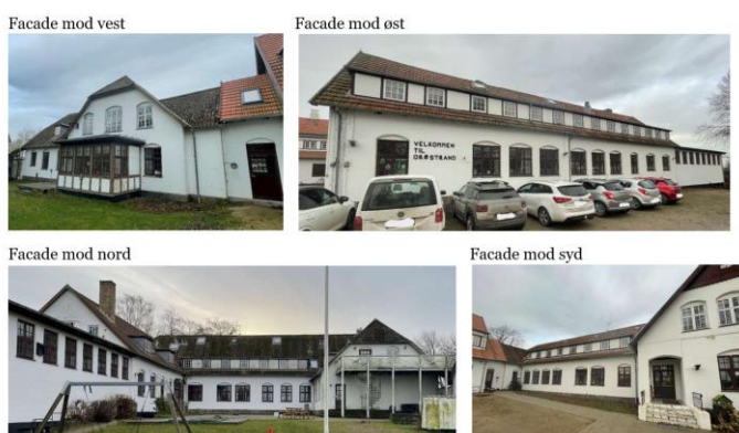
Fig. 3. Facadebilleder af eksisterende hovedbygning.
