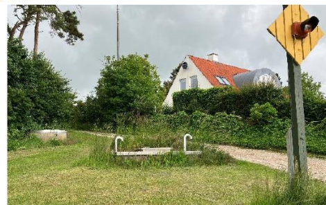
Figur 11: Eksempel på svanebals, her monteret direkte på pumpestation (på matr. nr. 6x, Lyndby by, Lyndby, ca. 280 m nord for den ansøgte placering af ny pumpestation).
