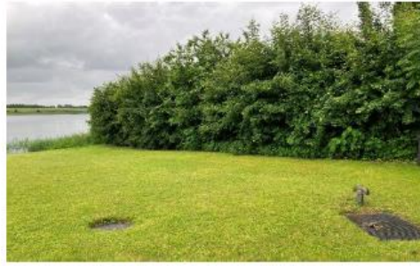
Figur 5: Eksisterende pumpestation på Hornsherredvej 192.
