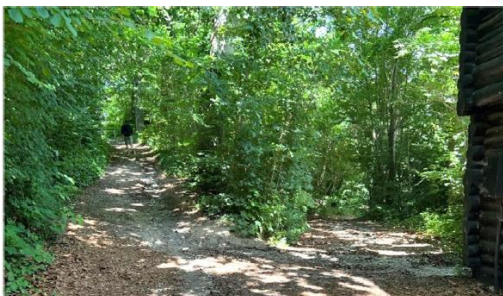
Figur 10: Adgangsvejen fra Hornsherredvej til gårdspladsen ses til venstre i billedet. Overfladevand har rendt af i højre side ad vejen og efterhånden udhulet vejens ene side.
