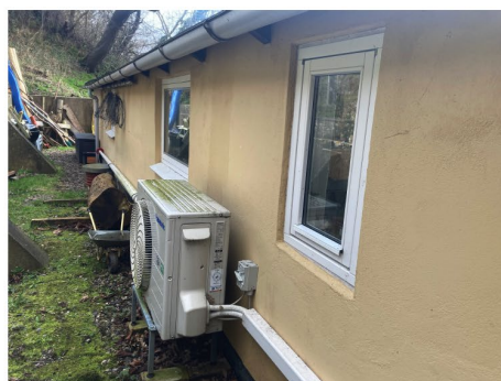
Nordsiden af huset
