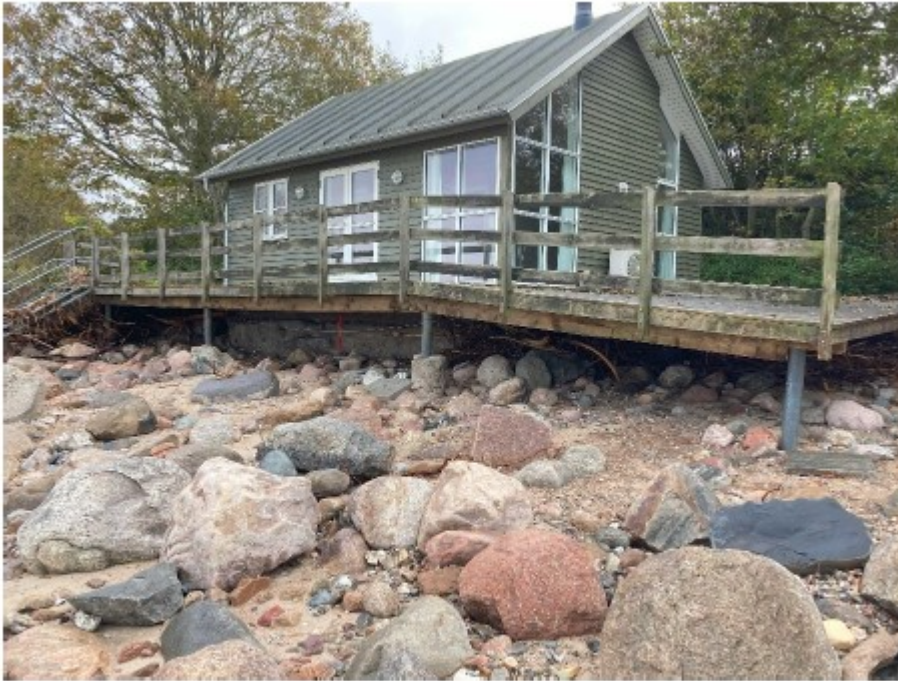
Hele fundament mod nord blotlagt.
