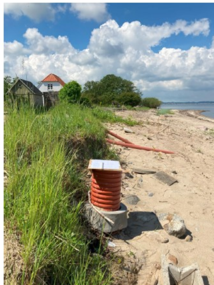
Ved NØ-hjørne set fra nord. Fundament blotlagt. Regnvandsbrønd til faskine blotlagt. Faskine væk.
