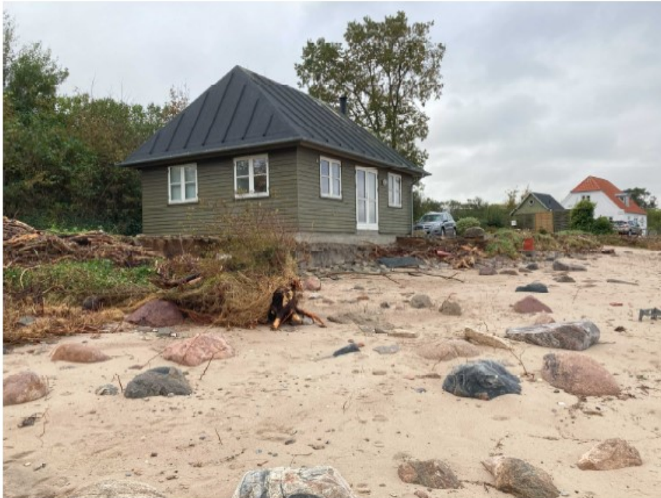
Hele fundament frilagt mod fjorden (nord) og del af fundament mod øst frilagt.
