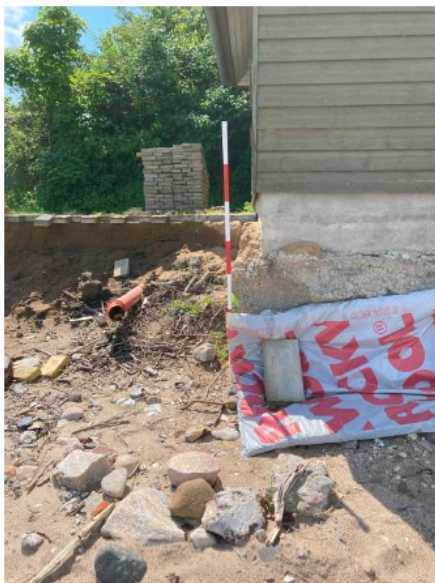
Ved NØ-hjørne set fra nord. Fundament blotlagt. Regnvandsbrønd til faskine blotlagt. Faskine væk.
