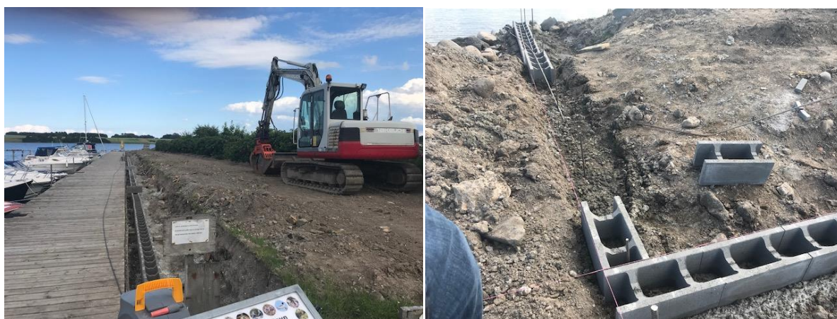
Fig. 8, 9 Etablering af betontkant på indersiden af sydmole
