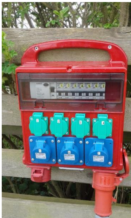
Fig. 12 Byggepladstavle til forårs/vinterklargøring. Fig. 13 Opstilling med elstander og vandpost
