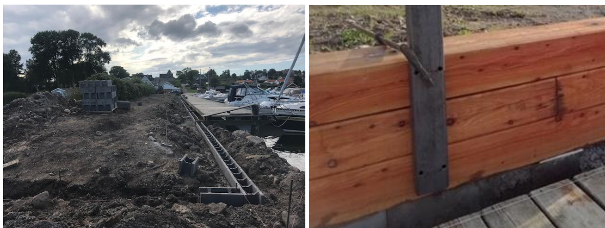
Fig. 10, 11 Første lag af fundablokke oven på randfundament samt 3 lag sveller som facade mod broværk.
