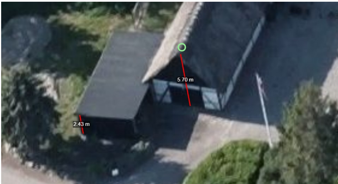
Kystdirektoratets opmåling viser den omtrentlige højde på de nedbrændte bygningerne. Opmålingen er foretaget på SDFE skråfoto.
