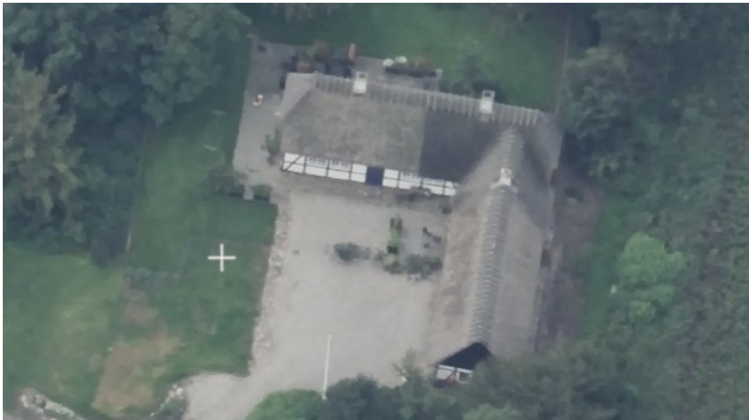
Skråfoto fra 2023 viser, at de nedbrændte bygninger er fjernet.
