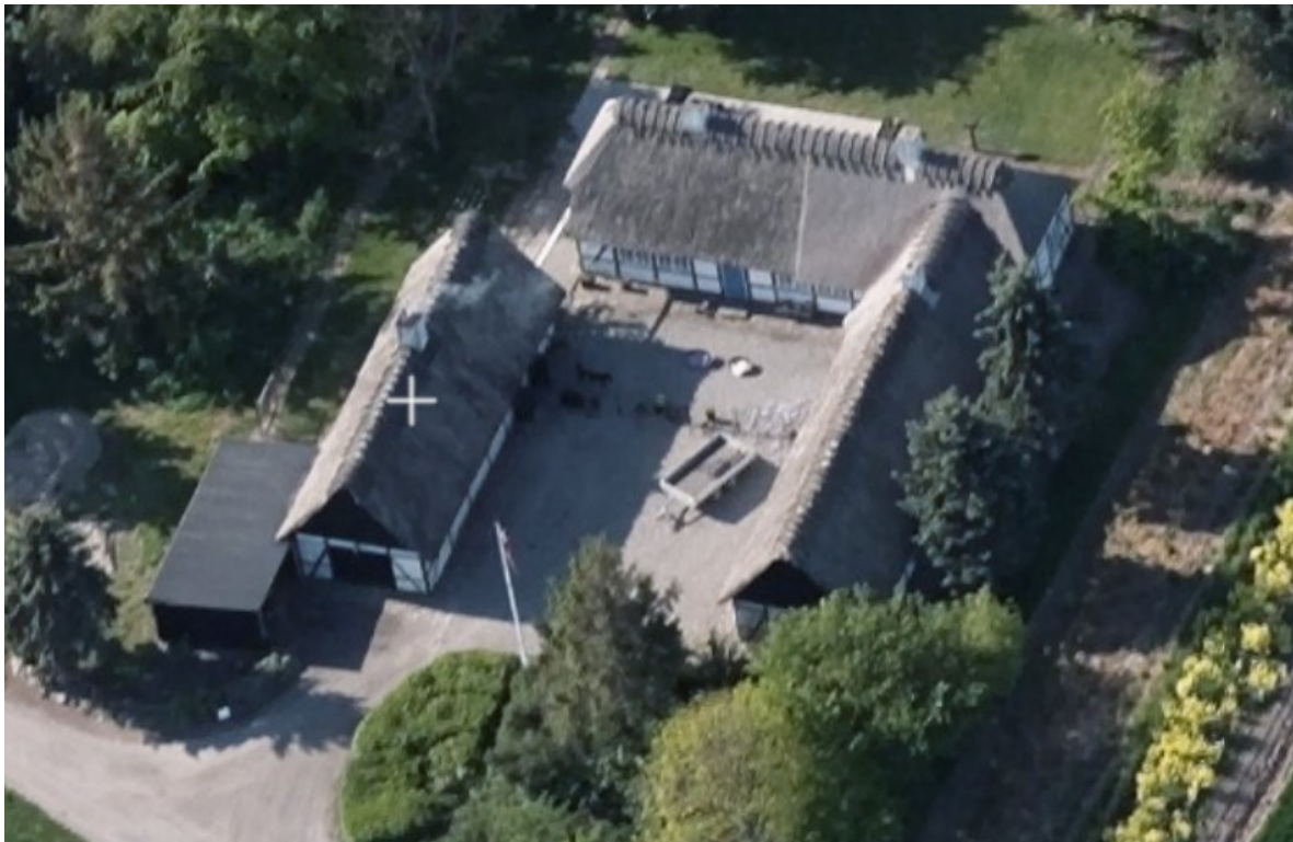
Skråfoto viser bygningerne på adressen set fra nord før branden. Jagthytten er markeret med hvidt kryds og til venstre herfor ses skuret.
