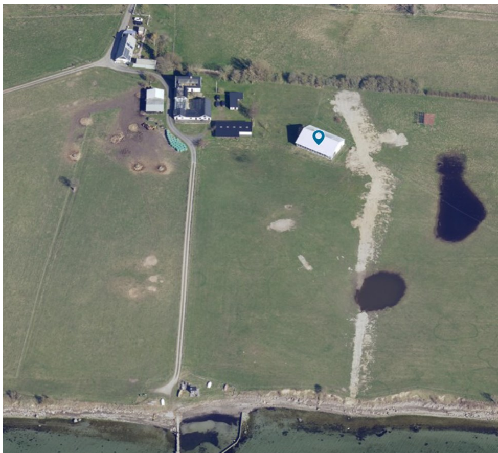
Skråfoto af området set fra øst. Bygning 5 er markeret med blå nål.
