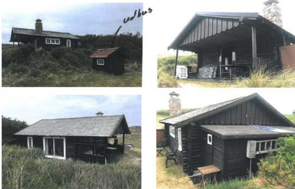
Fig. 2. Billeder fra ansøgningsmaterialet af det eksisterende sommerhus.
