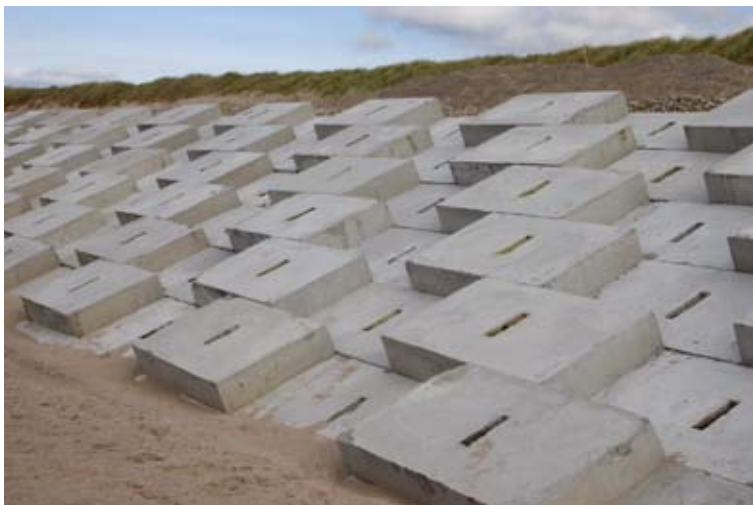
Fig. 5.4 Skråningsbeskyttelse inden tildækning med sand
