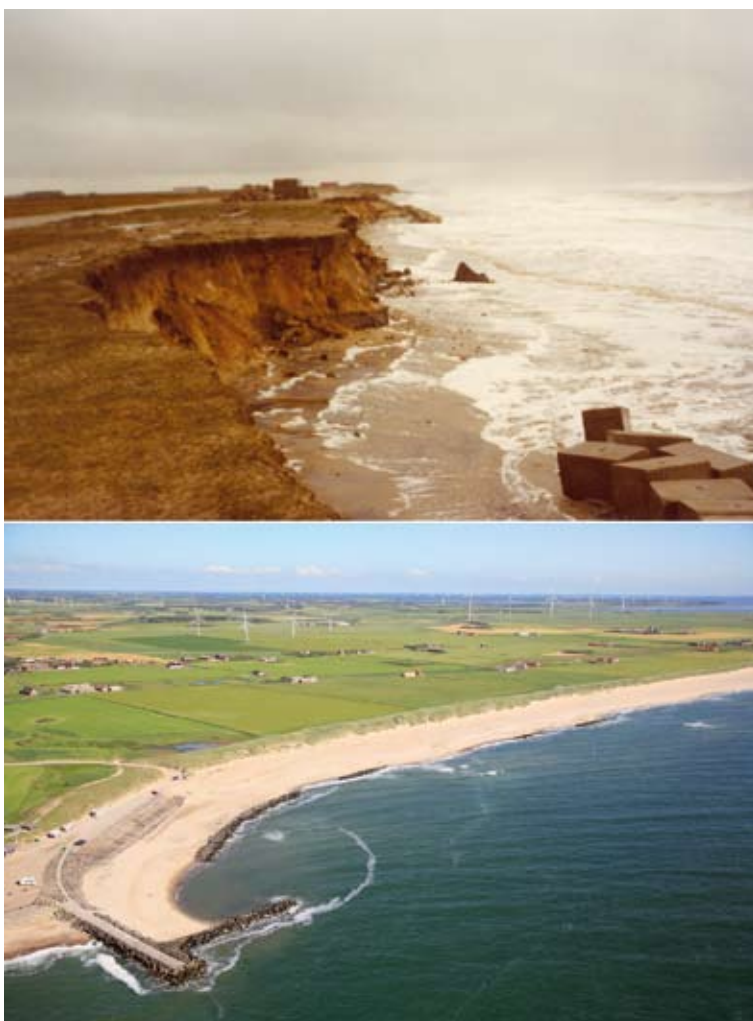
Fig. 5.6 Strækningen syd for hofde Q ved Fjaltring før og nu
