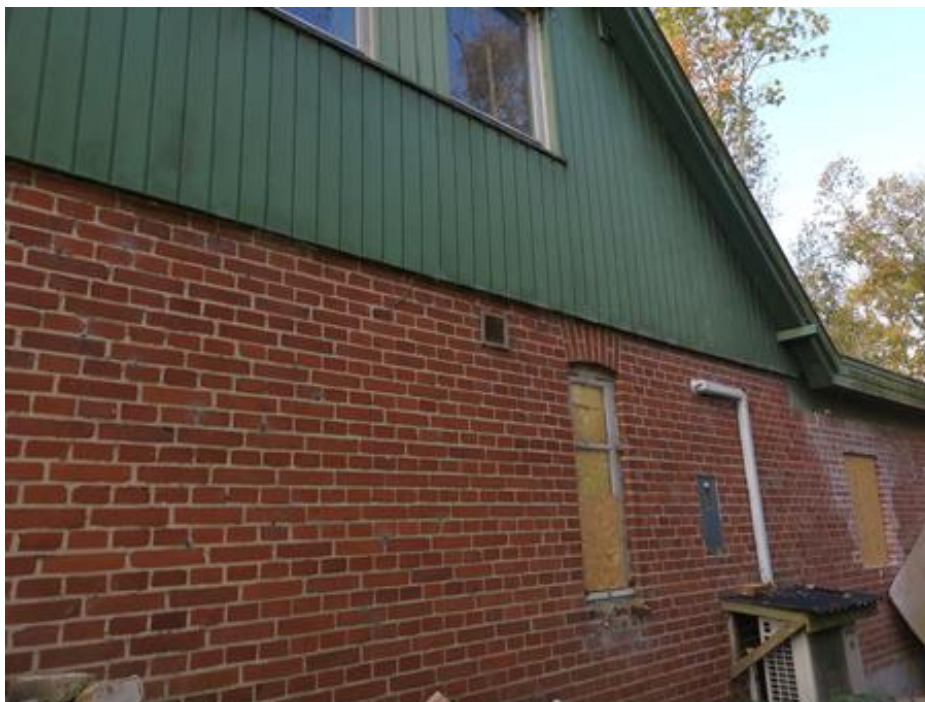
Fig. 8. Tilsendt foto af de eksisterende vinduer mod øst.
