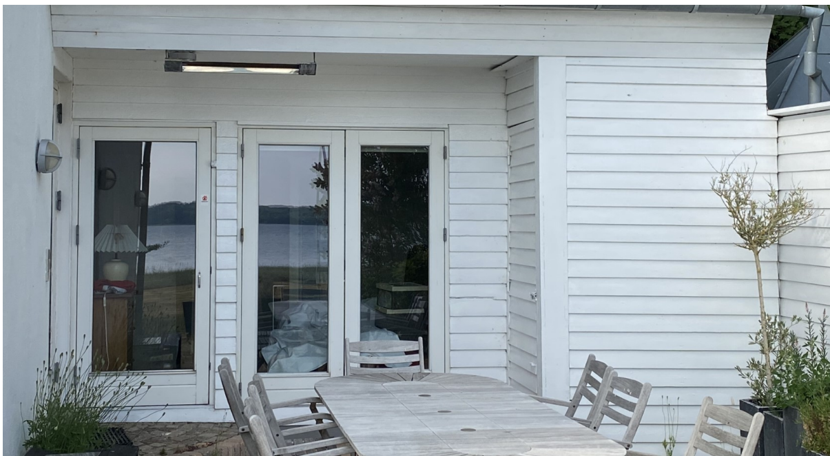
Foto af sidebygningens facade mod kysten (sydvest)
