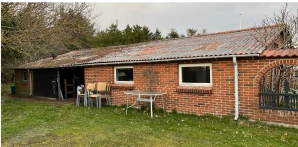
Figur 5 Nuværende Vest facade (vendende mod jernbane, væk fra vandet) med overdækket terrasse
