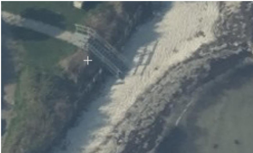
Skråfoto forår 2023. Trappen før stormfloden.
