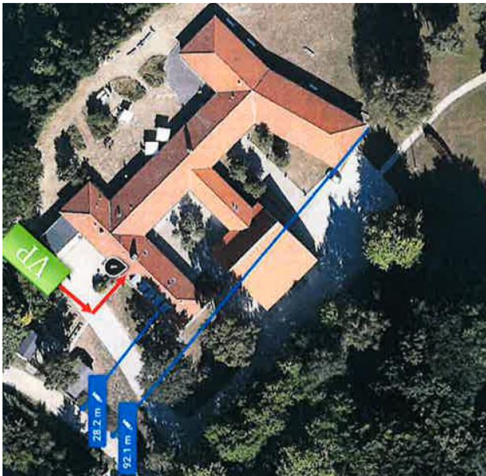
Fig. 2. På ovenstående fremsendte billedet illustreres placeringen af anlæg ved grøn VP markering og nedgravningerne af rør med røde pile.
