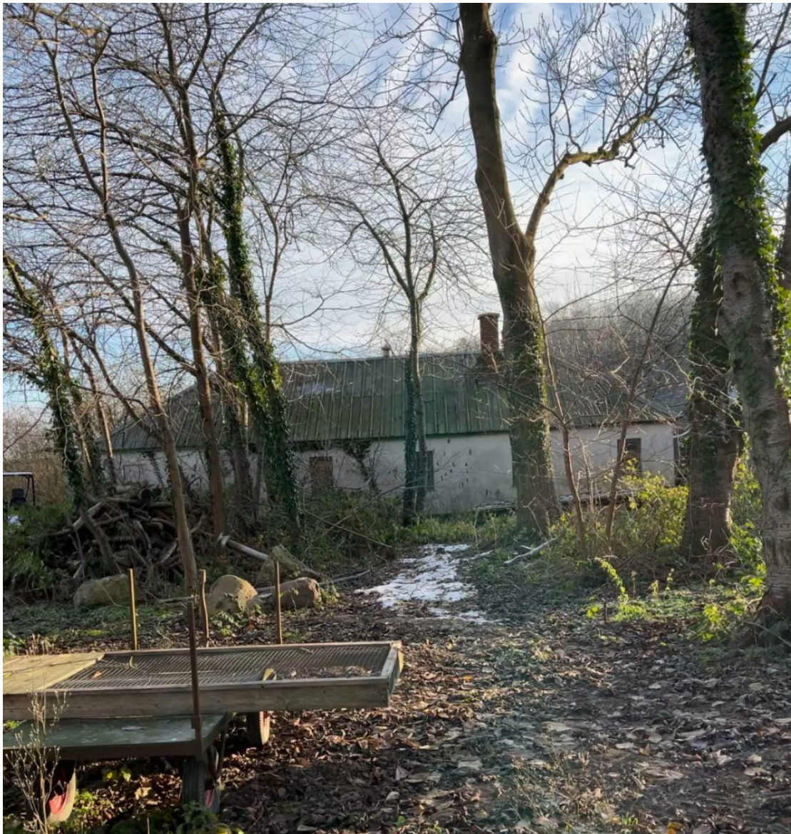
Fig. 2 Ansøgers foto af eksisterende ladebygning.
