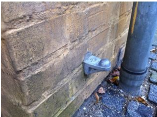
Figur 1: Nivellementsbolt – den mest udbredte etableringsform for fikspunkter.
