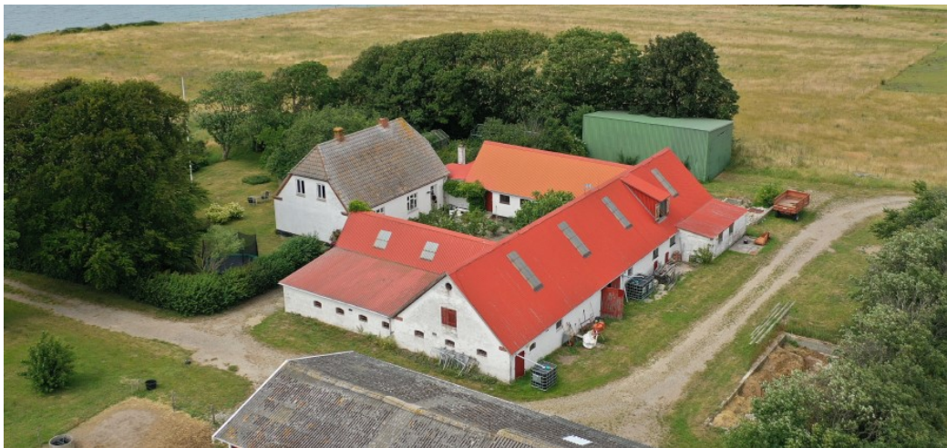
Luftfoto af eksisterende forhold. Bygning tre ses til højre på billedet og bygning 2 bagved til venstre for denne. Den lille tilbygning bagest til højre fjernes.
