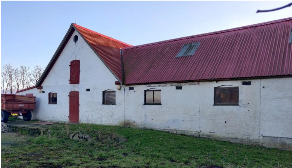
Eksisterende facade mod nord
