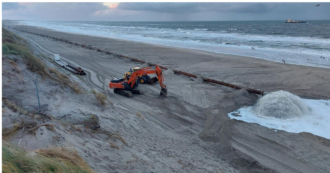
Figur 2-62. Strandfodring ved indpumpning af vandopblandet sand.
