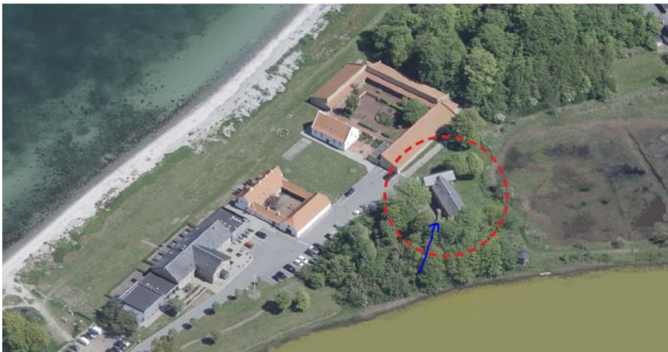
Varmepumper op lydvæg opstilles ved blå pil
