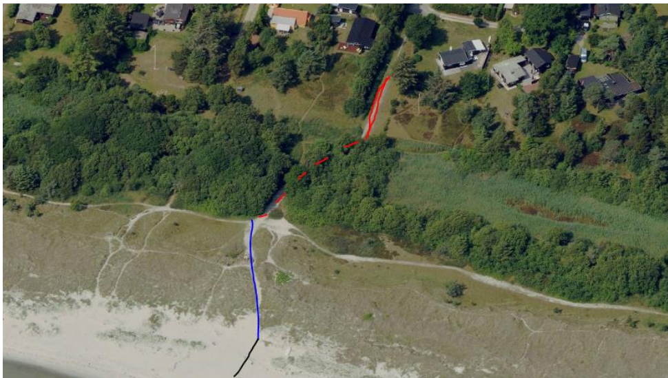
Rød: gravning i sti / blå: underboring klit / sort: gravning i stranden
