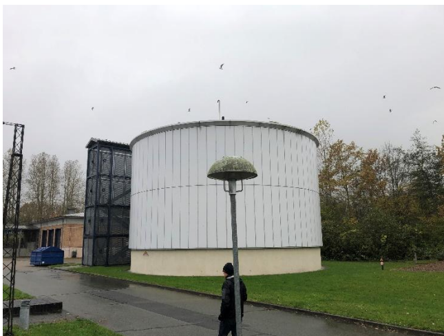
Bygning 9 –Rådnetank og trappetårn.
