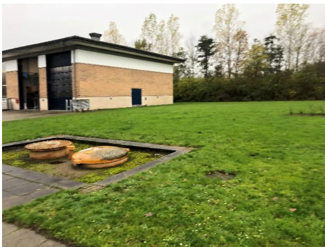
Bygning 12 – Nedgravede 15.000 l's kemikalie-tanke.
