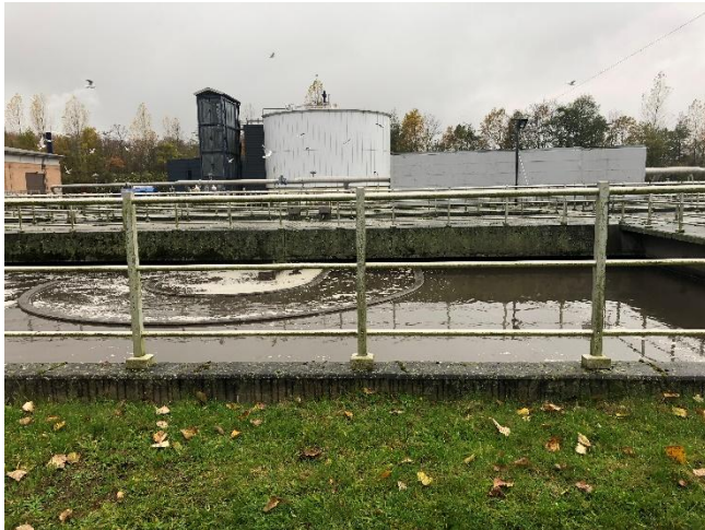
Bygning 4 – Beluftningstanke del 1, med rådnepark (bygning 6) i baggrunden
