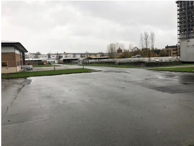
Oversigtsfoto 1 fra syd mod nord – i venstre side ses slampressebygning, i bunden midt for mandskabsbygning (nr. 6) og filterbygning (nr. 1), samt efterklaringstanke (nr. 2).
