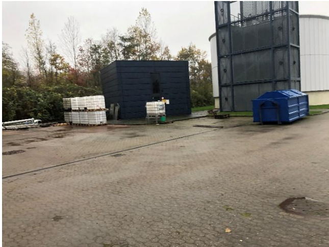
Bygning 10 – Gastank, kedelbygning og trappe-tårn til rådnetank (nr. 9)
