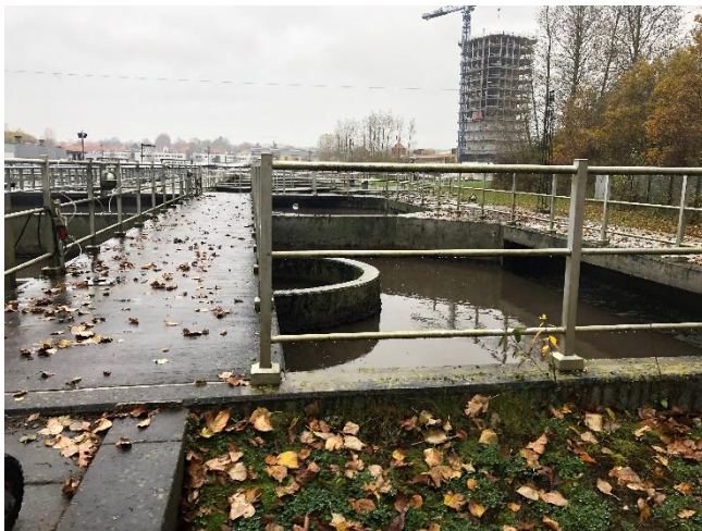
Bygning 5 – Beluftningstanke del 2.
