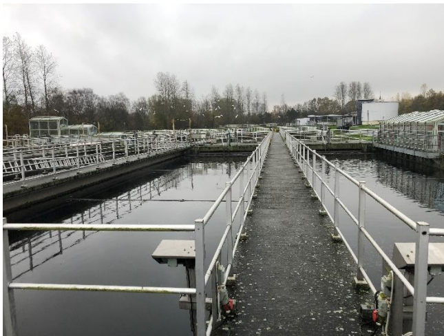
Bygning 2 – Efterklaringstanke
