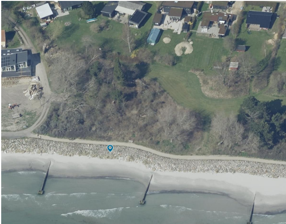
Skråfoto af eksisterende forhold ved Hjulsporet 22. Blå pil markerer ønsket placering af trappen. Stien ligger omtrent i DVR-kote 3.
