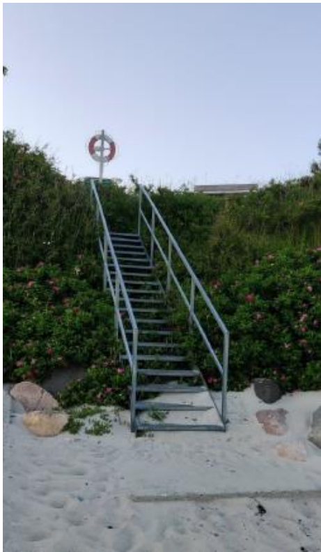
Foto af en af de eksisterende trapper over diget – placeret mellem de to ansøgte trapper.
