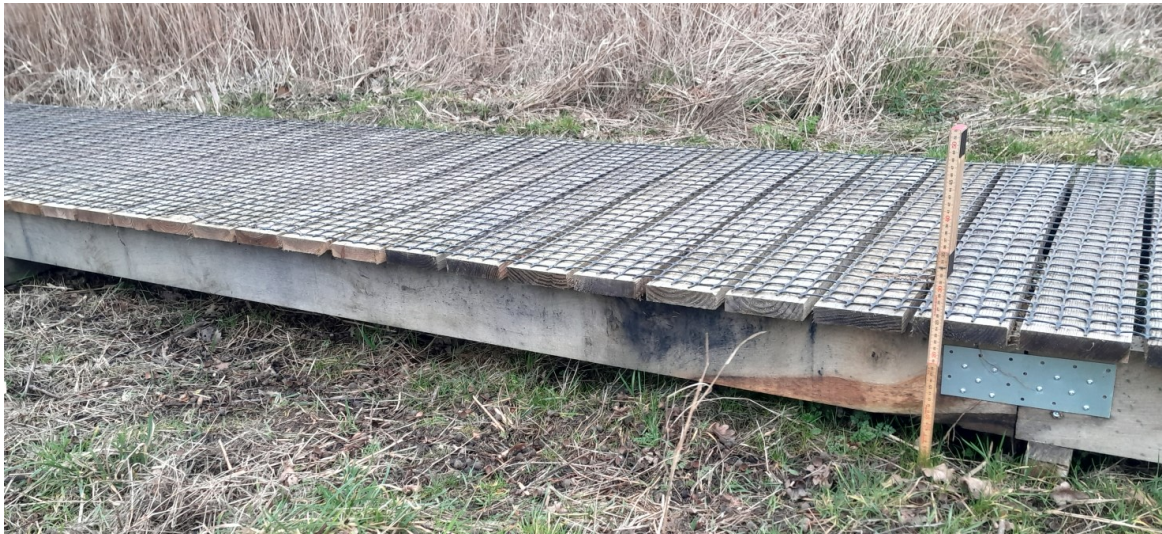
Eksempelvisning af konstruktionen. Tommestokken viser, at gangfladen her er hævet ca. 25 cm over terrænet.
