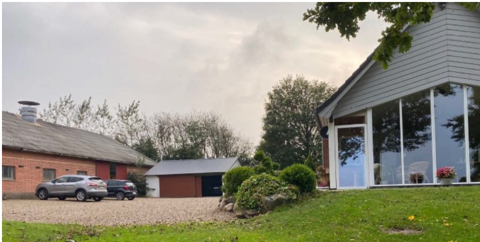
Foto fra øst. Stuehuset ses til højre, i midten gårdspladsen og garagen. Til venstre ses ladens nordvendte facade.
