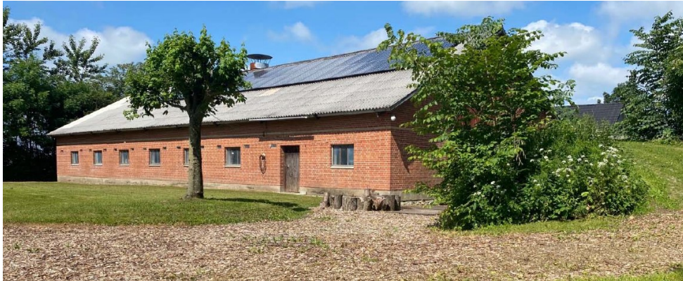
Eksisterende lade set fra syd. Til højre på billedet ses en rampe, der fører til loft/1.sal på laden.
