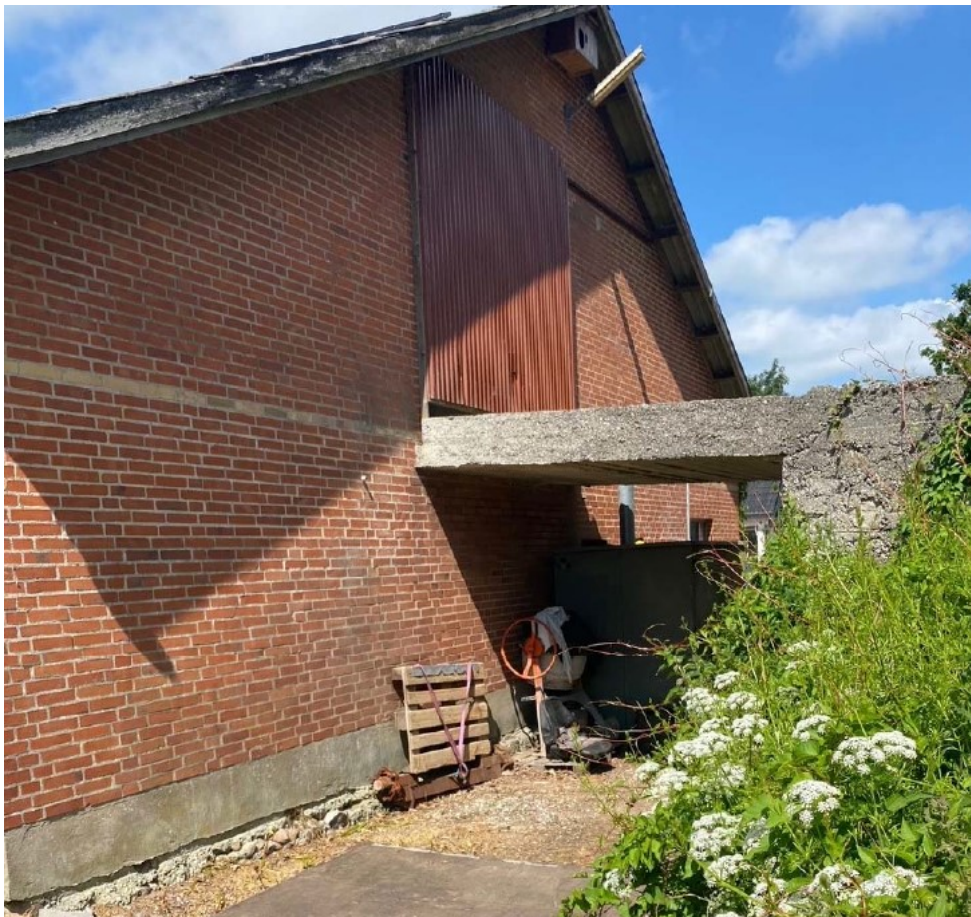
Foto af ladegavlen mod øst/kysten. En betonbro fører fra rampen over til porten til loftet/1.salen på laden.
