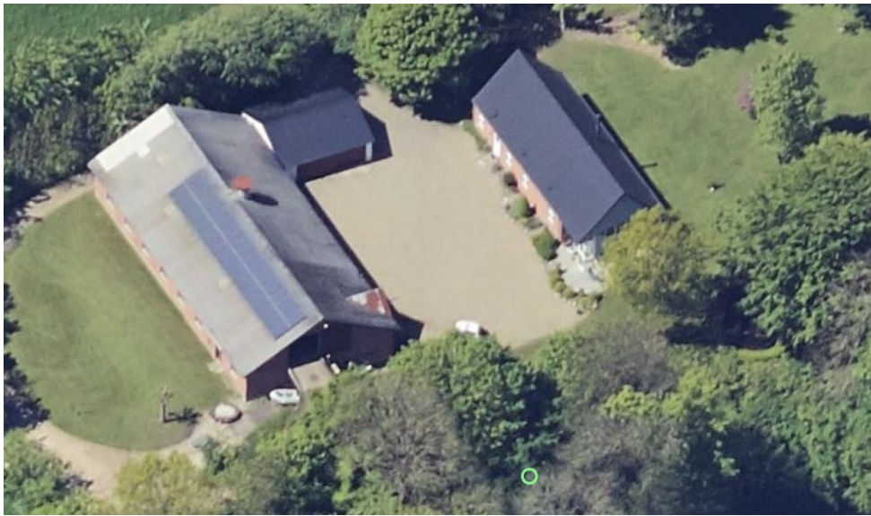
Luftfoto af ejendommen fra øst. Nuværende stuehus ses mod nord (højre). Nuværende lade ligger syd herfor på den anden siden af gårdspladsen. I den vestlige ende af gårdspladsen mellem stuehus og lade ligger garagen.
